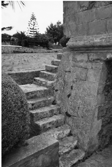
Abb. 8: Campanile , Treppenaufgang ins 1. Obergeschoss
