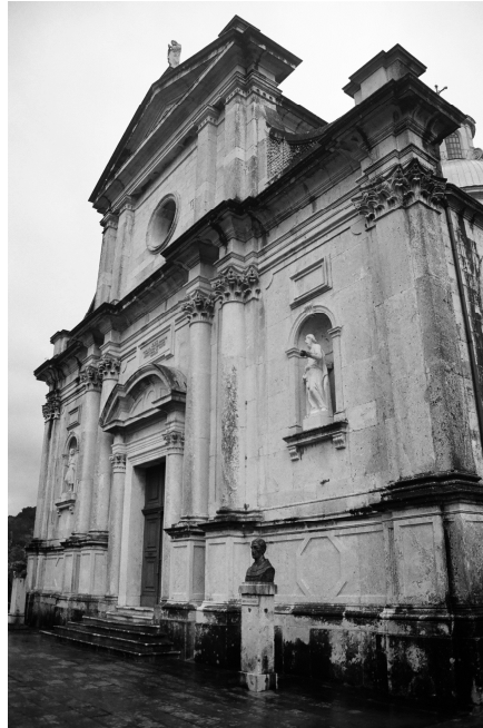
Abb. 16: Marienkirche, Westfassade (Baubeginn 1789), Perzagno (Venezianisch-Albanien)
