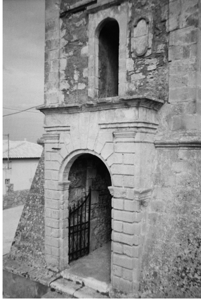
Abb. 6: Campanile , Portal von Südwesten
